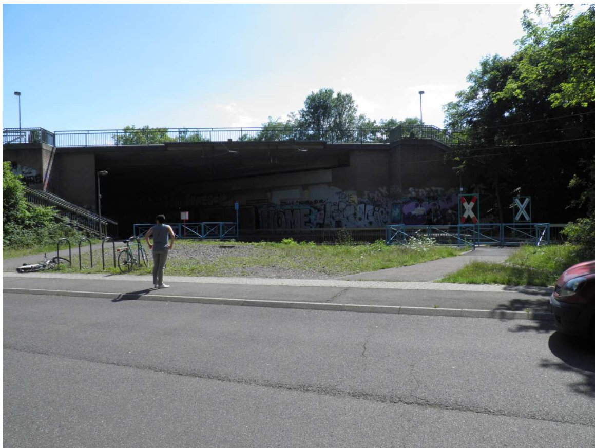
Bild 4: möglicher B+R-Platz an der „Neue Straße“ neben der Haltestelle Westhoven-Kölner Straße
